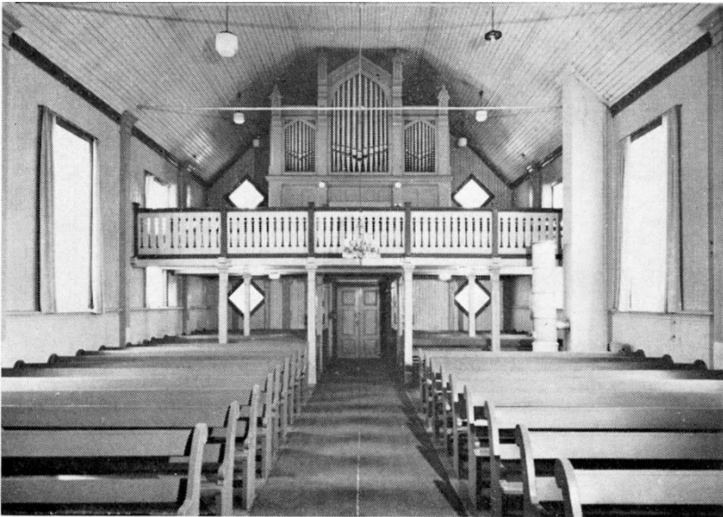
Interiør fra kirken før restaureringen 1969.
